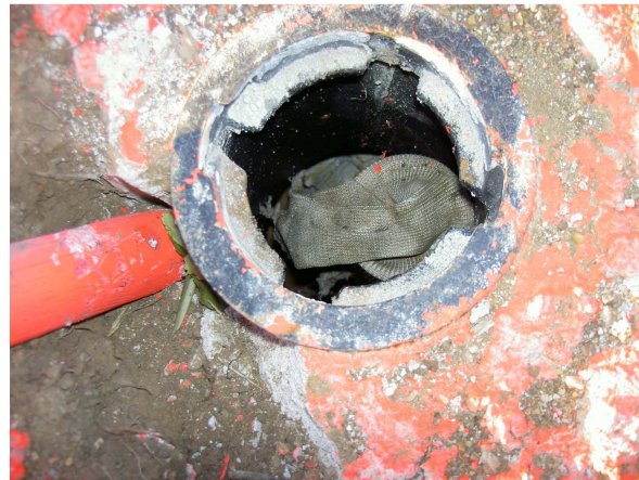
Intérieur du piézomètre PZ1
